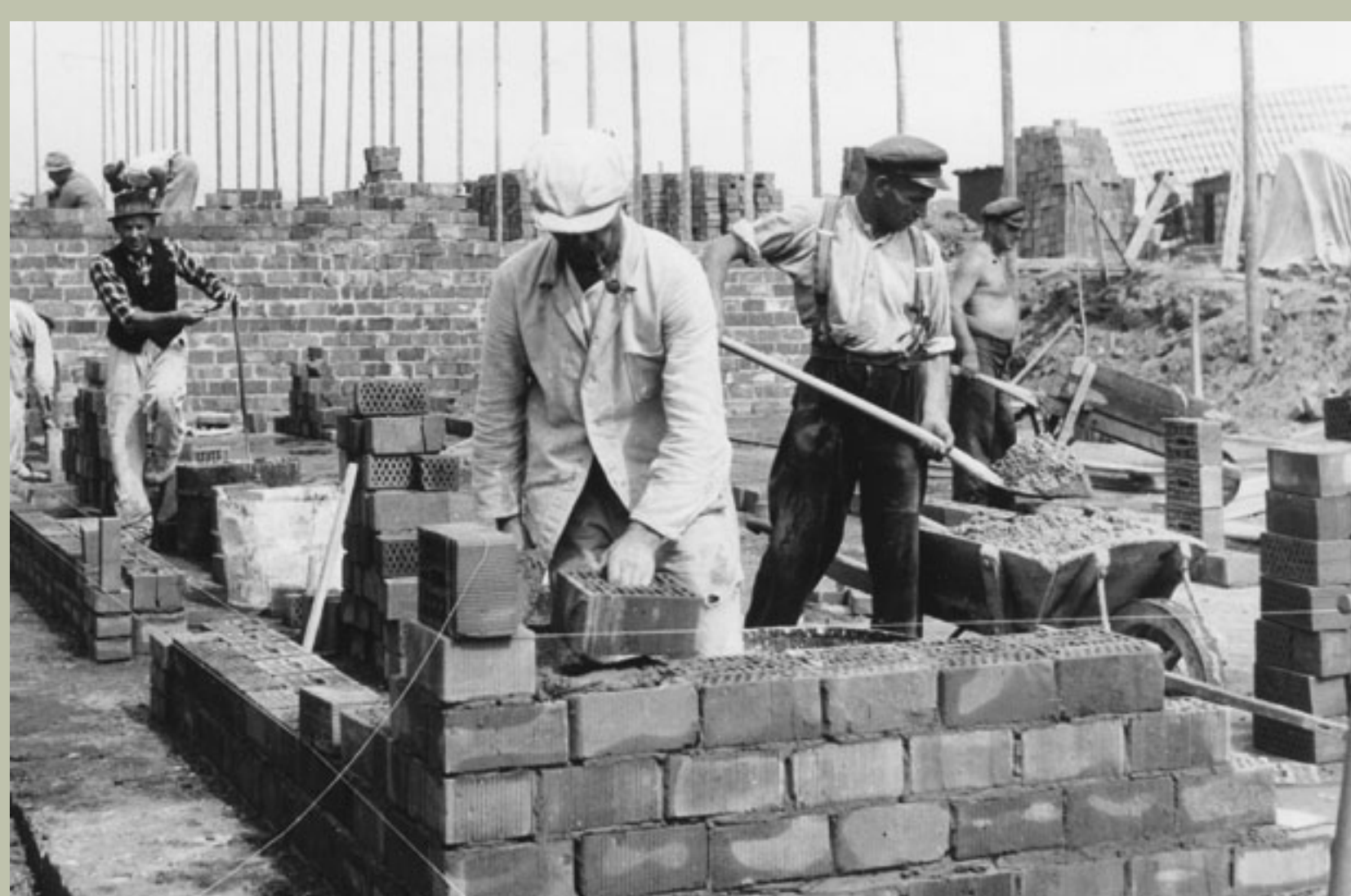
Wiederaufbau des Bremer Westens, Grundsteinlegung an der Wartburgstraße durch die »Gemeinnützige Wohnungsbaugesellschaft Bremen mbH« (GEWOBA) 1953. In den fünfziger Jahren werden in Bremen zahlreiche Bauprojekte nach den Prinzipien des »verdichteten Wohnraumbaus« umgesetzt. © StAB, Fotograf: Karl Edmund Schmidt
